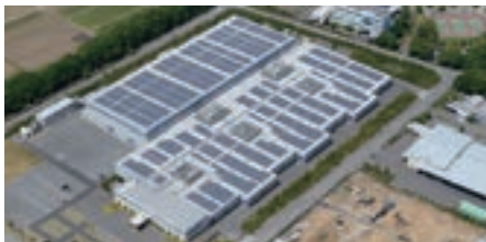
埼玉工場太陽光発電所
