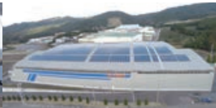
滋賀工場太陽光発電所
