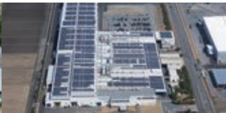
群馬工場太陽光発電所
